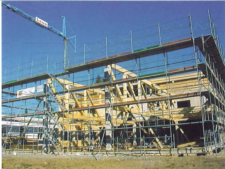
Zwei Parallel-Fachwerkträger bilden das Primärtragwerk, an dessen Ober- und Untergurten Brett-schicht-verleimte Neben-träger als Sekun-därtragwerk an-geschlossen sind (Fotos, rechts).
