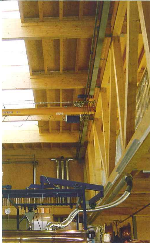
Zwei Parallel-Fachwerkträger bilden das Primärtragwerk, an dessen Ober- und Untergurten Brett-schicht-verleimte Neben-träger als Sekun-därtragwerk an-geschlossen sind (Fotos, rechts).
